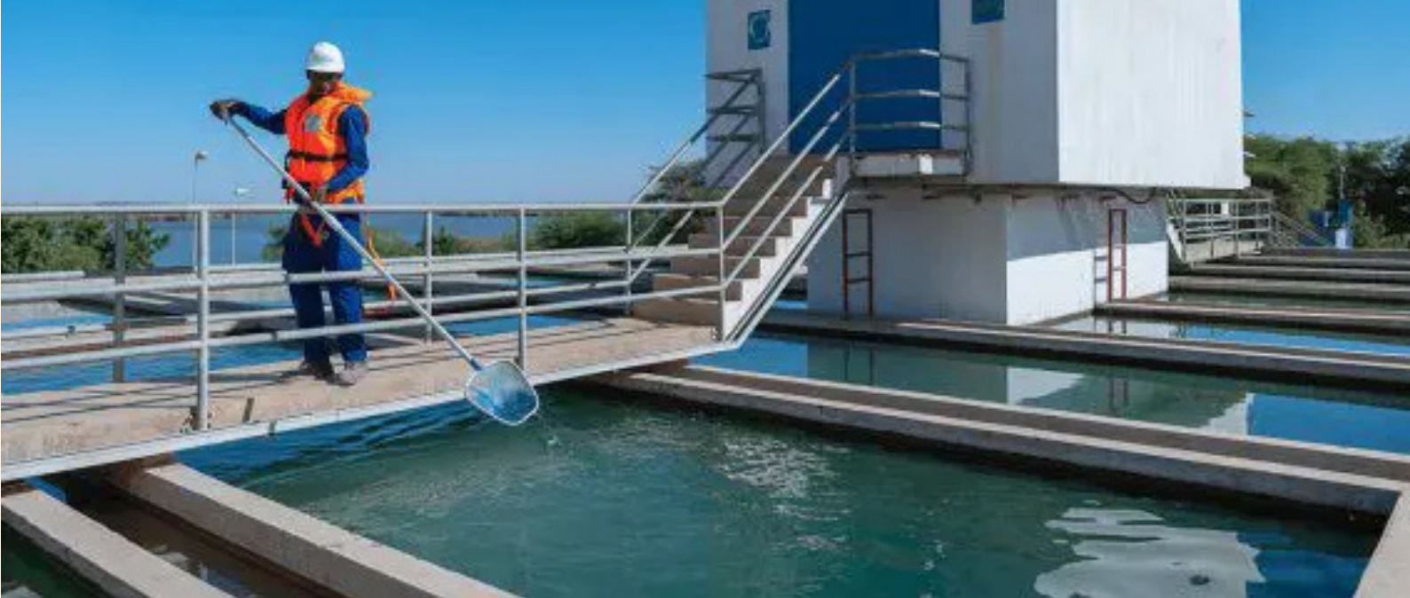
Usine de traitement des eaux usées
